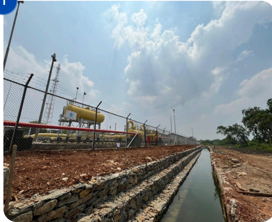
PEKERJAAN PERBAIKAN PENURUNAN TANAH STASIUN MUARA BEKASI PGASOL-PGN
